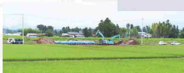
決壊した名蓋川堤防の補修工事の様子(7月19日 古川矢目)
