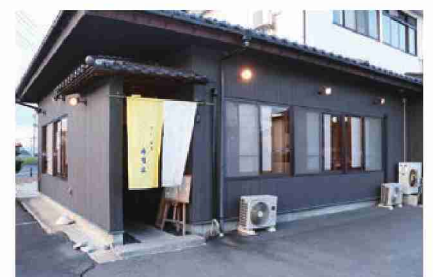
国道4号線沿いにあるお店の外観
