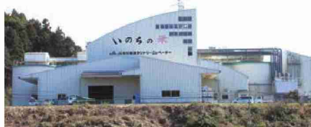
南部カントリーエレベーター
